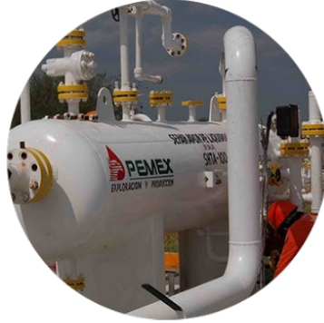
Mantenimiento y rehabilitación a separadores y válvulas de alivio
