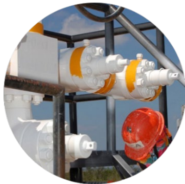
Lubricación y mantenimiento a árboles de producción
