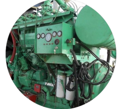
Mantenimiento a sistemas de bombeo para trasiego e inyección
