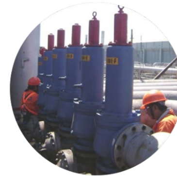
Mantenimiento a válvulas de seguridad
