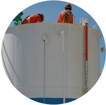
Mantenimiento a equipos de seguridad para tanques de almacenamiento atmosféricos
